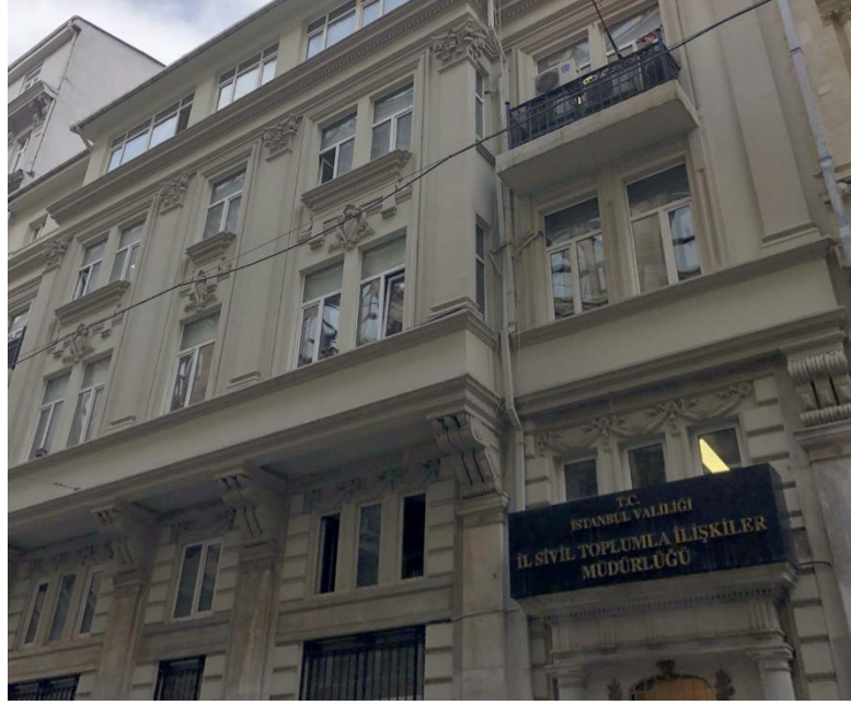
Görsel 5. Narlıyan Han güney cepheden ayrıntı.
