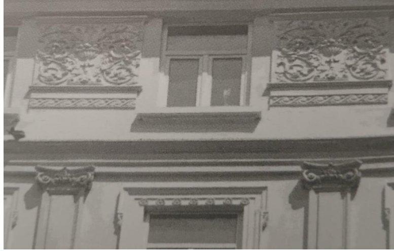
Görsel 5. Vefai Han güney cephe dekorasyonundan ayrıntı.
