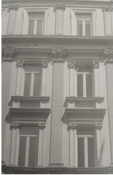
Görsel 4. Vefai Han güney cepheden ayrıntı.
