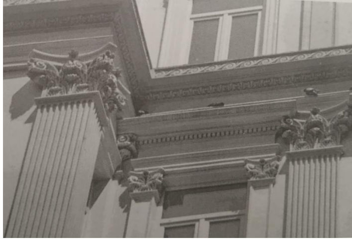
Görsel 6. Vefai Han güney cephe plasterlerden ayrıntı.
